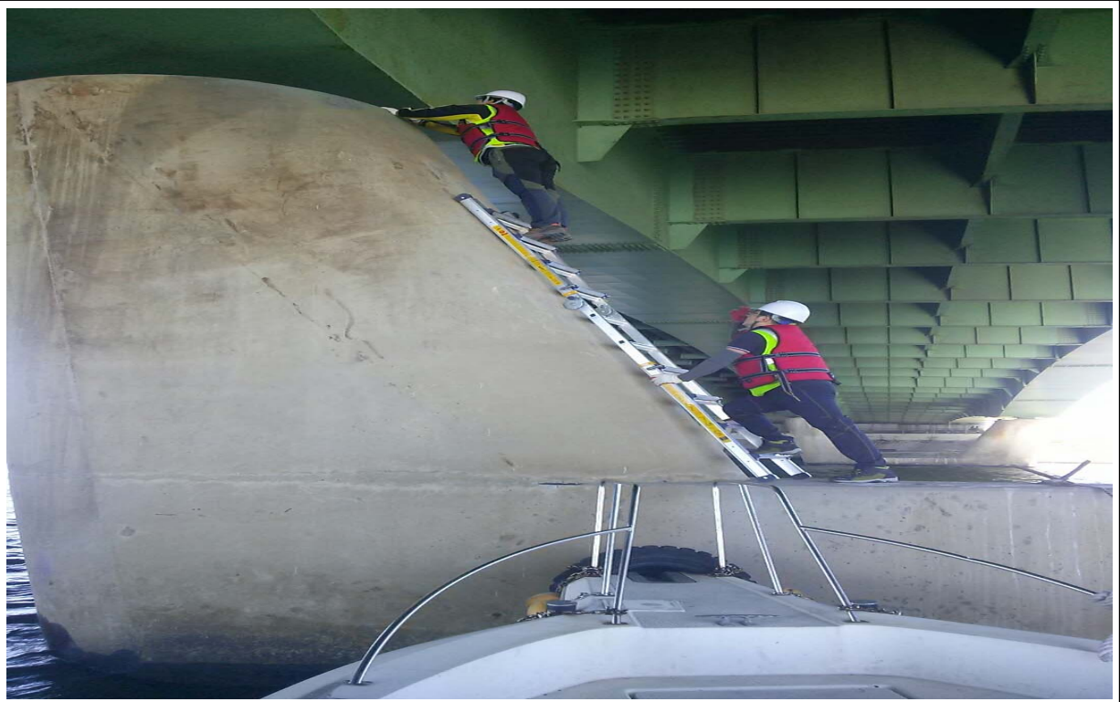
사다리를 이용한 외관조사
