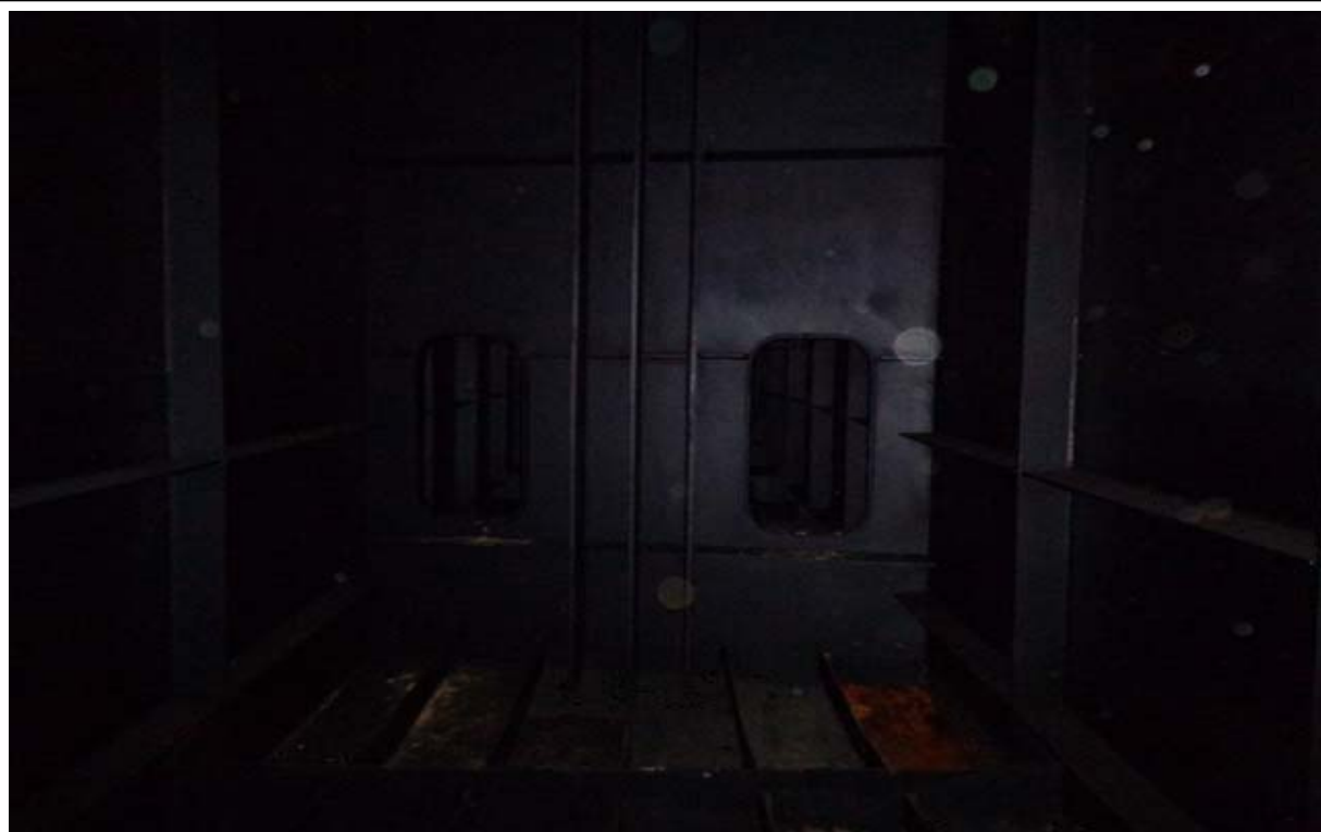
거더 내부 전경
