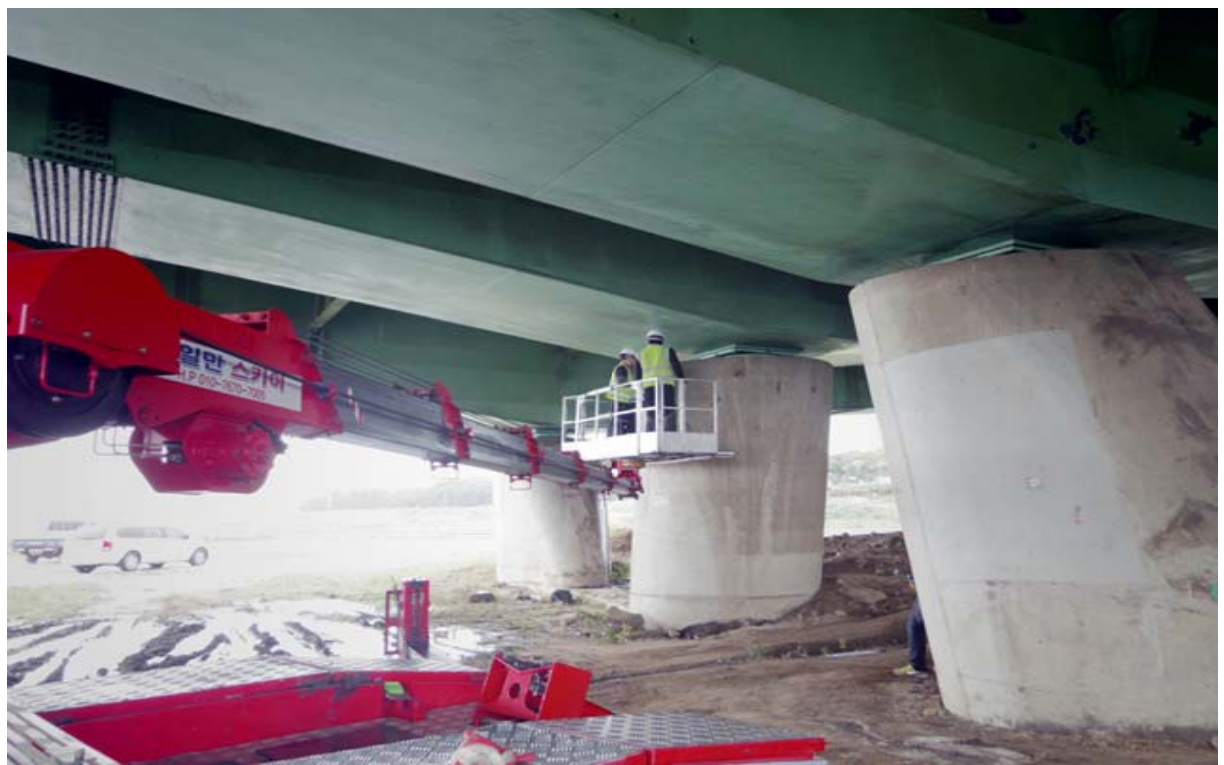
고소차를 이용한 하부비파괴 시험
