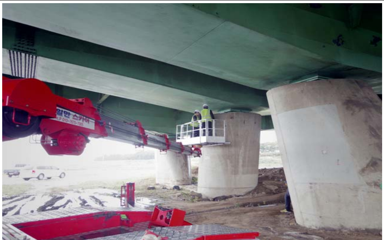
점검차를 이용한 외관조사(바닥판하면)
