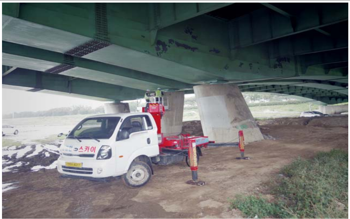
점검차를 이용한 외관조사(바닥판하면)
