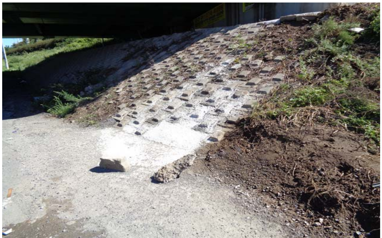
교대 공동구간 보수 (A2)
