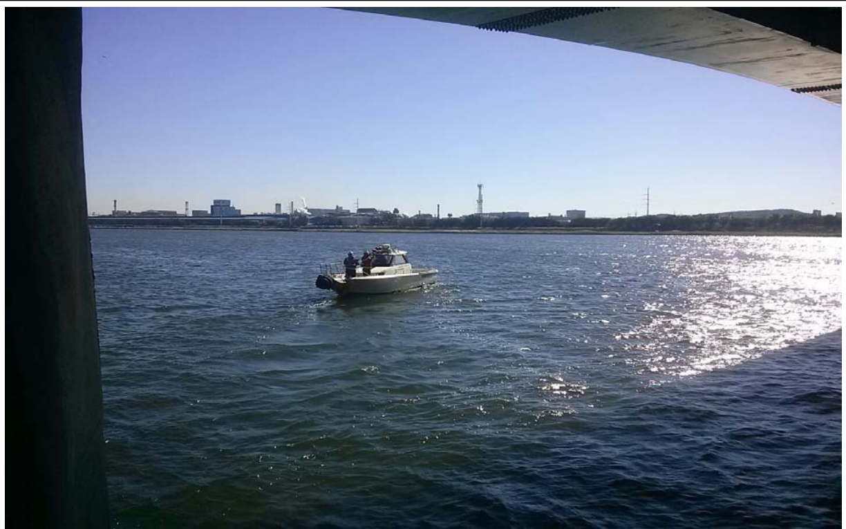
보트를 이용한 외관조사
