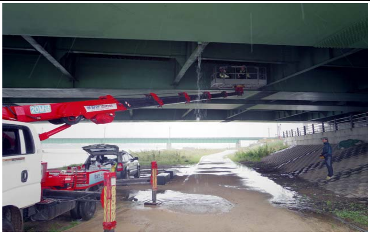
배수시설 S1 배수시 하부 자전거 도로로 떨어짐
